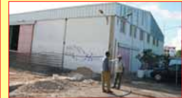
Les travaux en cours
