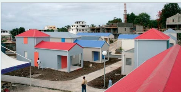
le quartier de Bonan en cours de rénovation
