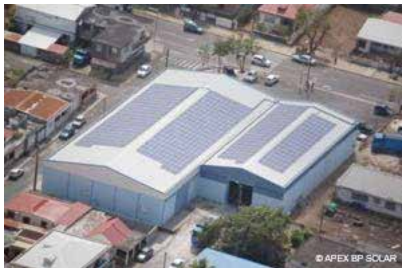
Installation photovoltaïque sur un bâtiment de la commune du Moule Source : Apex BP Solar
