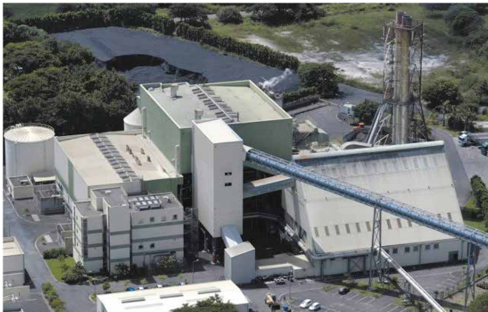
Centrale thermique du Moule Source : Guadeloupe énergie
